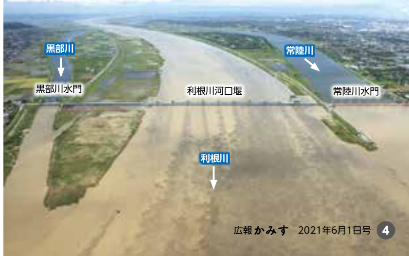
平成27年9月関東・東北豪雨で逆流を防止した様子。常陸川水門の上流と下流で水の色が違う
