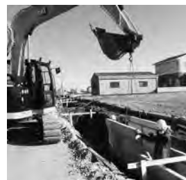
雨水排水対策工事
