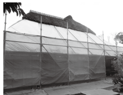
工事中の様子(2022年3月撮影) 茅葺屋根の下半分が撤去されました
