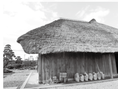
工事前の様子(2020年10月撮影) 屋根の一部に緩みが生じ、下がってきています
