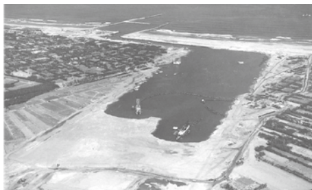
鹿島港中央航路掘削の様子(昭和40年代)
