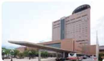
鹿島セントラルホテル
