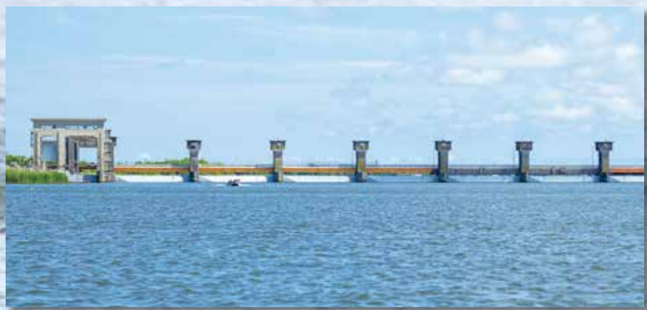
常陸利根川と逆水門
