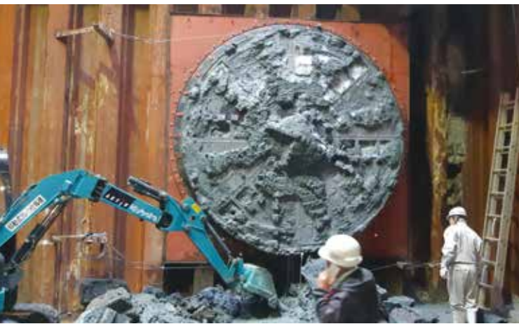
目標の到達地点まで掘り進み、泥だらけになって姿を現した推進機(写真中央)
