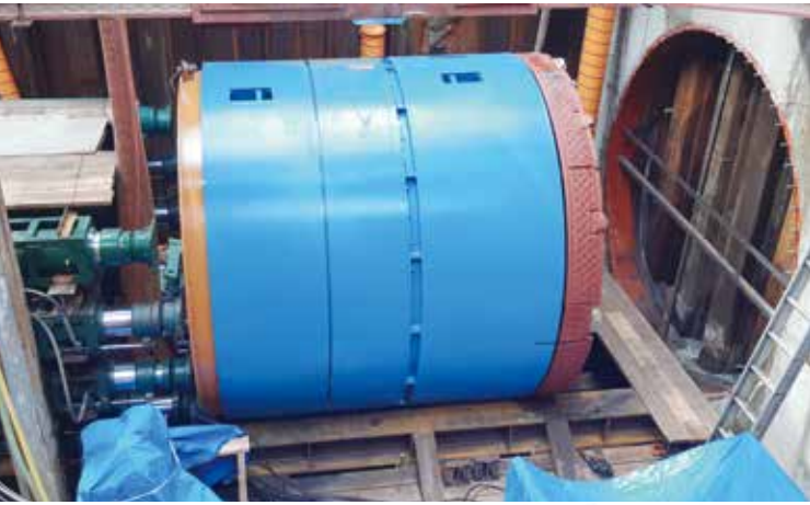
鹿島港に雨水を放流する「放流渠」整備で、地中を掘り進めた推進機
