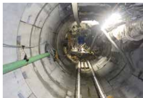
深さ9メートルの地下に造られたトンネル
