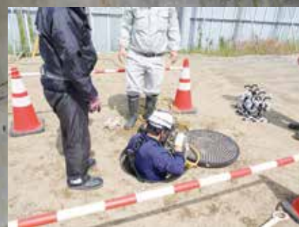
直径60センチのマンホールから地下へ潜入
