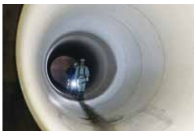
完成した巨大雨水管
