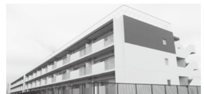
市営日の出町住宅
